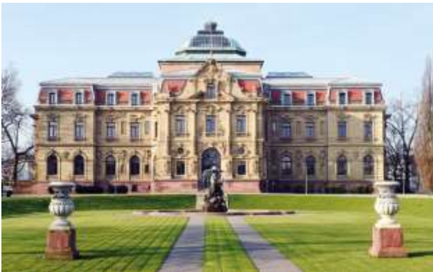
Foto : Der Bundesgerichtshof in Karlsruhe
